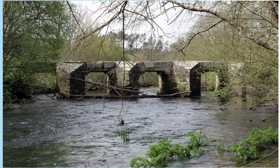
A Ponte Dona, entre Coristanco e Ponteceso
